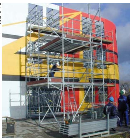
W ramach zajęć praktycznych dla montażystów rusztowań Ośrodek współpracuje z firmą Peri Polska. Na zdjęciu ściana treningowa Peri w Płochocinie
